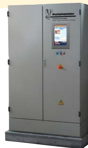
Quadro elettrico con Pannello Operativo
