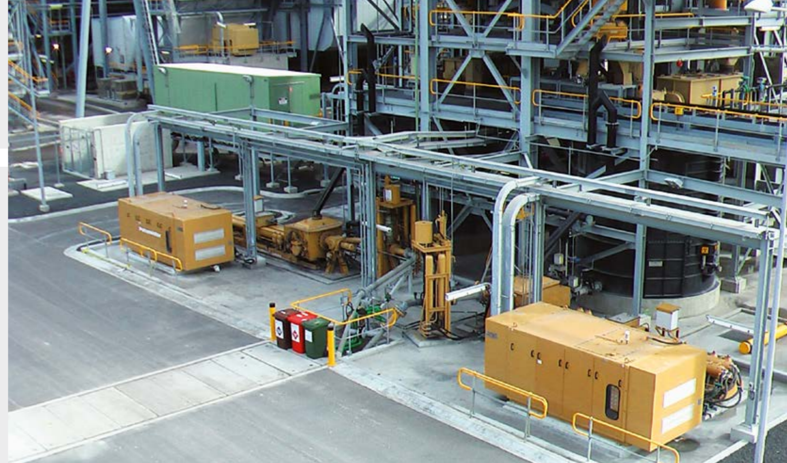
Trasporto di notevoli quantità di ceneri volatili e pesanti da centrale elettrica
